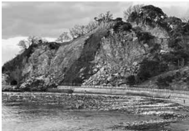
袖ヶ浜海水浴場の隆起とトンネル崩壊
